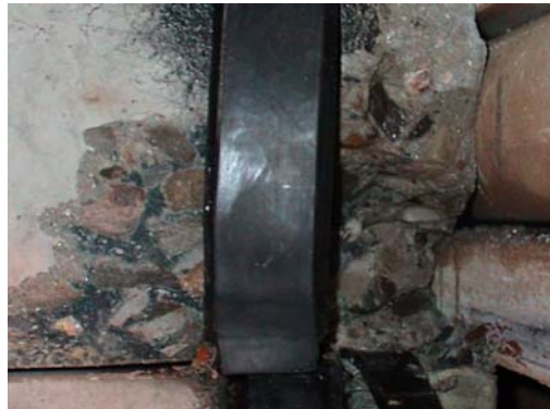
Figuur 34: Betonschade door raken schild
