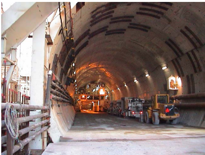
Figuur 1: Begin boortunnel Groene Hart
