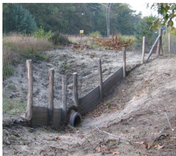
Een dassentunnel onder het spoor. (Foto: ProRail)
