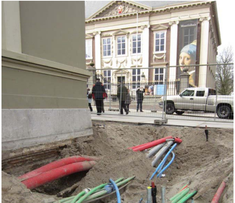
Kabel- en leidingwerk voor ondergrondse uitbreiding van het Mauritshuis. (Foto: IbdH) >> LEES HET ARTIKEL IN DE VERDIEPING
