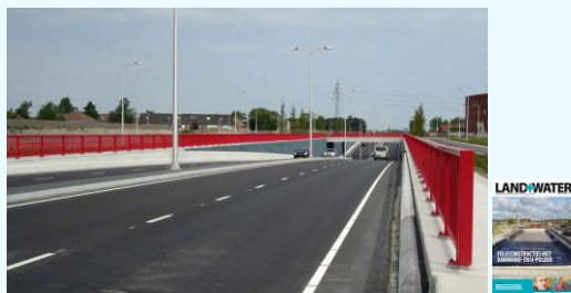
Referentie: Maester / Gerritsen, Folieconstructies met damwand-polder en U-polder te Assen, Land+Water, mei 2009
