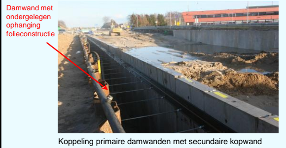
Koppeling primaire damwanden met secundaire kopwand
