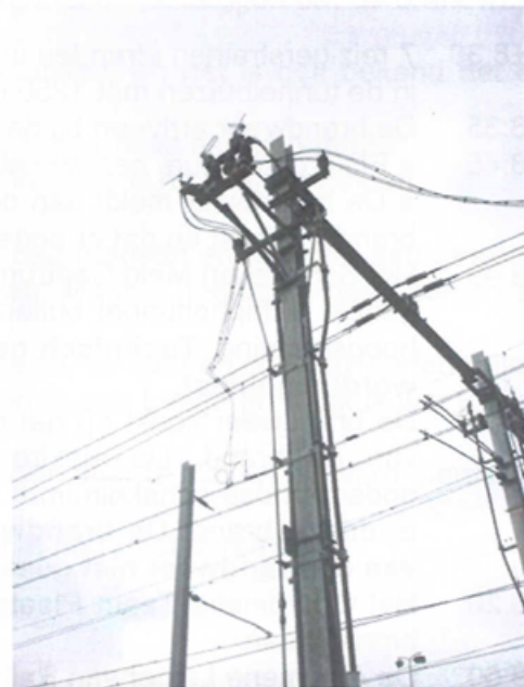
Afb. 8. Een portaal met twee normale bovenleidingschakelaars, één in geopende stand en één in gesloten stand. Door het wegknippen van de kabels kan de verbinding tussen bovenleiding en voeding worden verbroken
