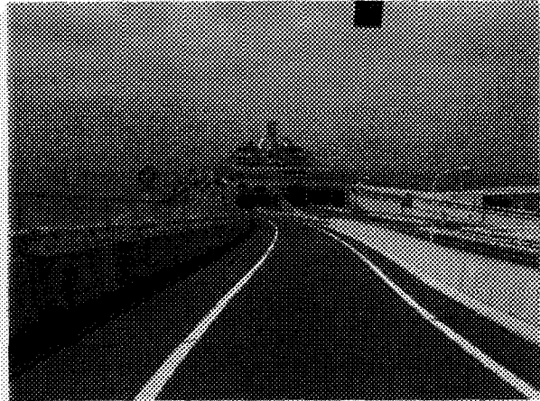
Figuur 14 Tokyo Trans Bay Aqua Line tunnel - noordportaal
