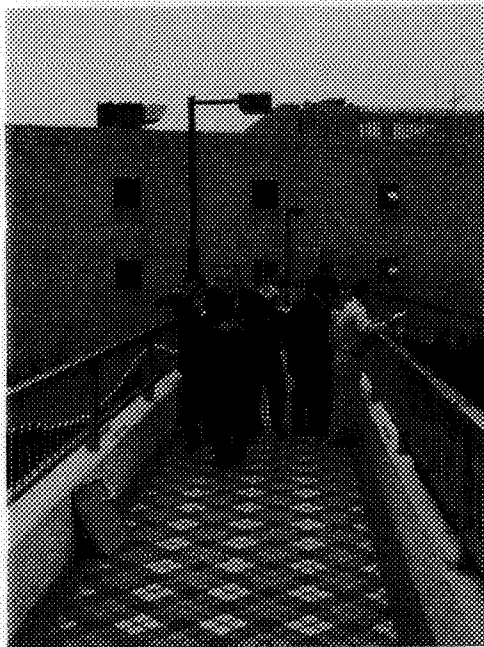
Figuur 9 Verbindende loopbrug
