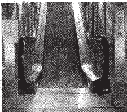
Figuur 4. De lange roltrap van straat naar perron, 12.08 m opvoerhoogte (maten rechts in centimeters; op- en aantrede resp. 20.6 en 39.5 cm).
