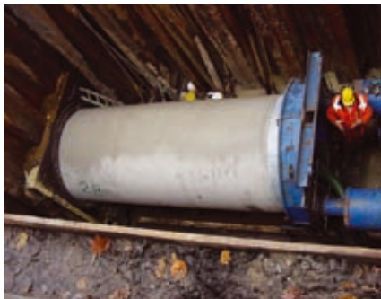
Afbeelding 6.6 Voorbeeld van een boring
