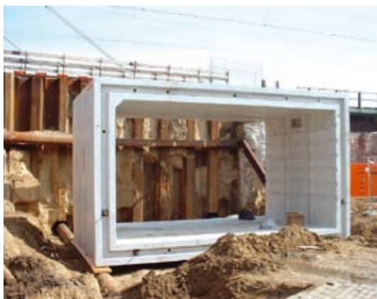
Afbeelding 6.1 Prefabtunnelement
