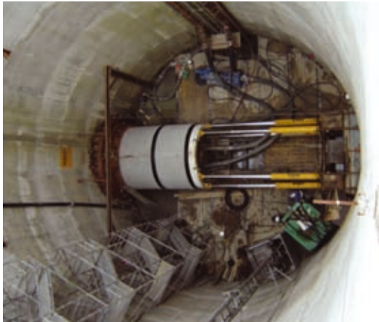
Afbeelding 6.9 Voorbeeld van schachtconstructie bij boring
