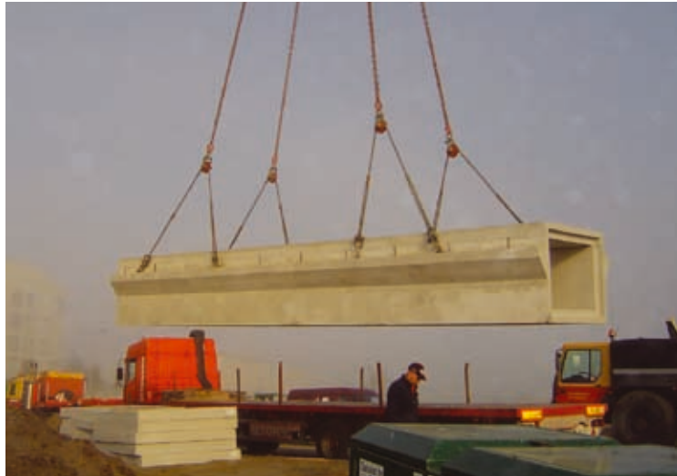
Afbeelding 6.2 In te graven tunnelement
