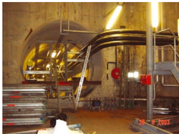
Afbeelding 6.5 Schachtvloer Leidingentunnel Oude Maas
