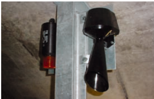
Afbeelding 7.6 Ontruimingssignaal Calandtunnel (hoorn en flitslicht)
