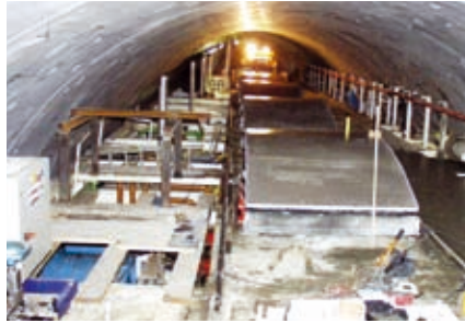
Afbeelding 6.8 Tunnel gebouwd met ringbouwmethode
