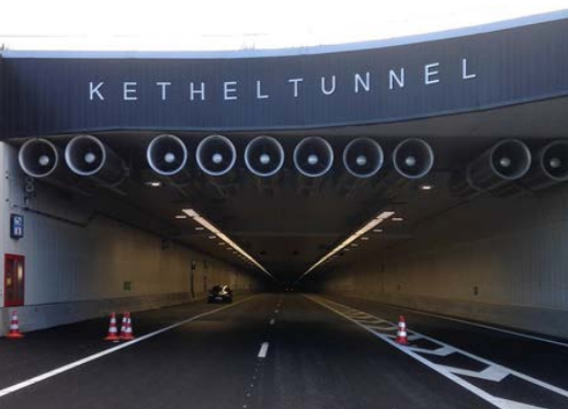
De Ketheltunnel was een van de casestudies voor het Centrum Ondergronds Bouwen.
