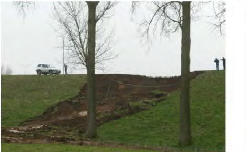
Figuur 9: Weergave dijkverzakking bij Stein (Bron: RWS)
