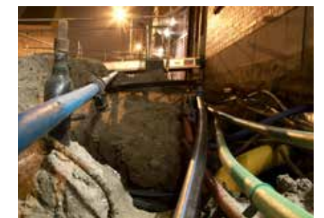
Bij de aanleg van de spoortunnel in Delft was er weinig tot geen ruimte voor tijdelijke en definitieve kabel- en leidingtracés. (Beeld: Flickr/Sander van der Wel)
