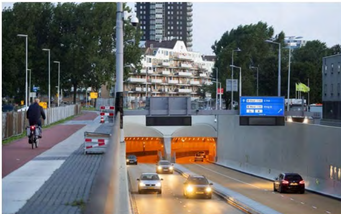
Na een renovatie die iets meer dan twee jaar heeft geduurd is de Rotterdamse Maastunnel weer in beide richtingen open voor gemotoriseerd verkeer. ANP OLAF KRAAK
